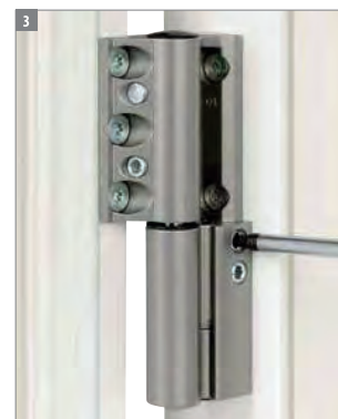
3. Po zakończeniu regulacji należy zablokować śrubę kontrującą.
